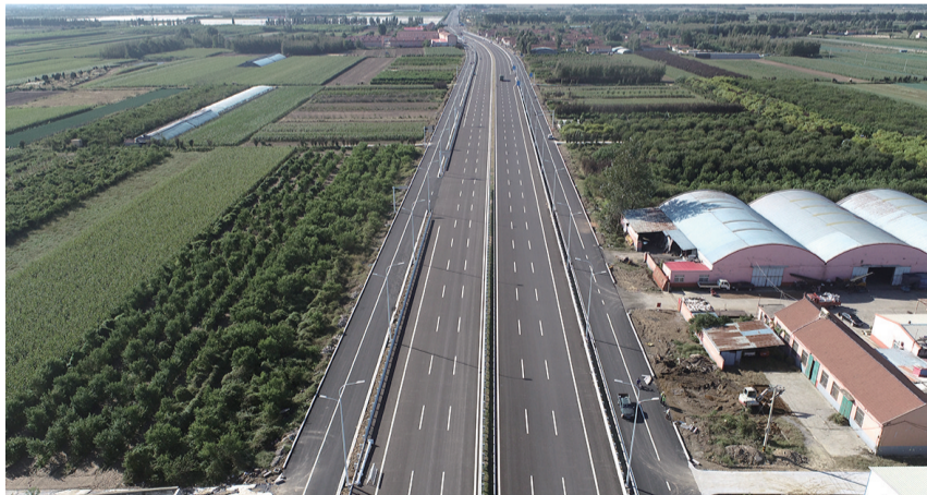
主线贯通的省道219平度段拓宽工程。建设方供图
