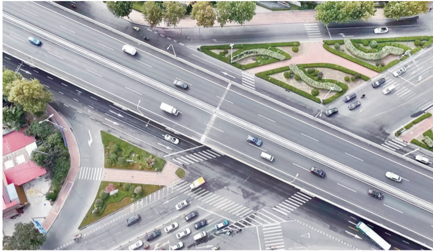
恢复通车的西流高架桥。
