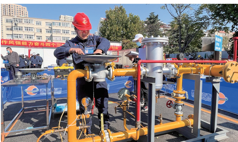
参赛职工现场在燃气调压区对设备进行检测调试实操。
