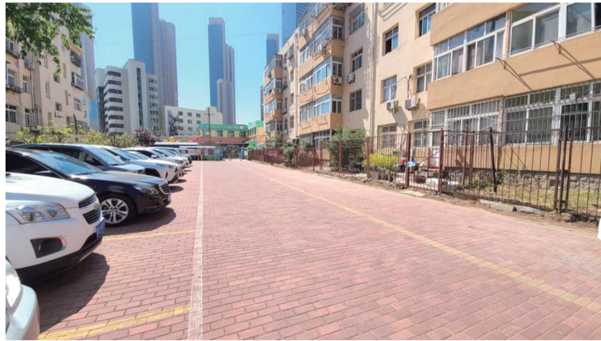
改造后的南通南路2号小区内增加了50个停车位满足居民停车需求。
