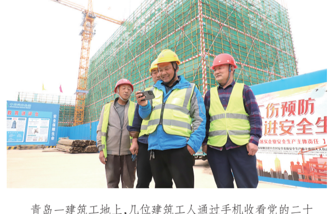
青岛一建筑工地上，几位建筑工人通过手机收看党的二十大开幕会盛况。 观海新闻/青报全媒体记者 李德银 摄
