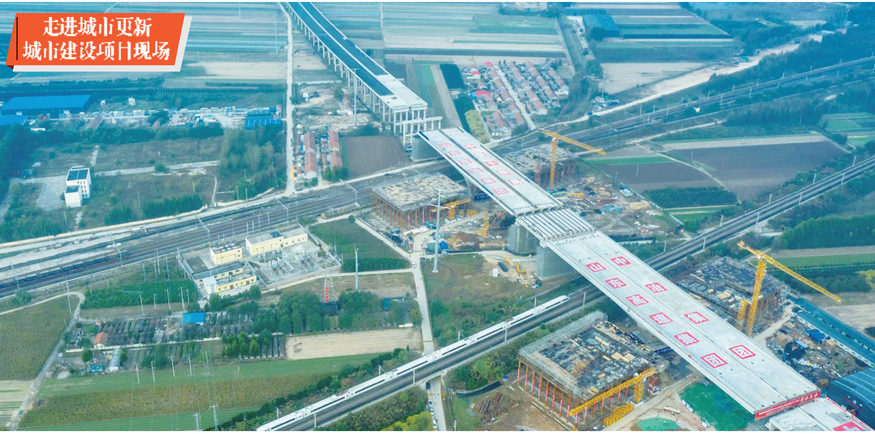
潍青高速跨胶济客运专线、胶济铁路两个转体桥空中精准对接。 建设单位供图
