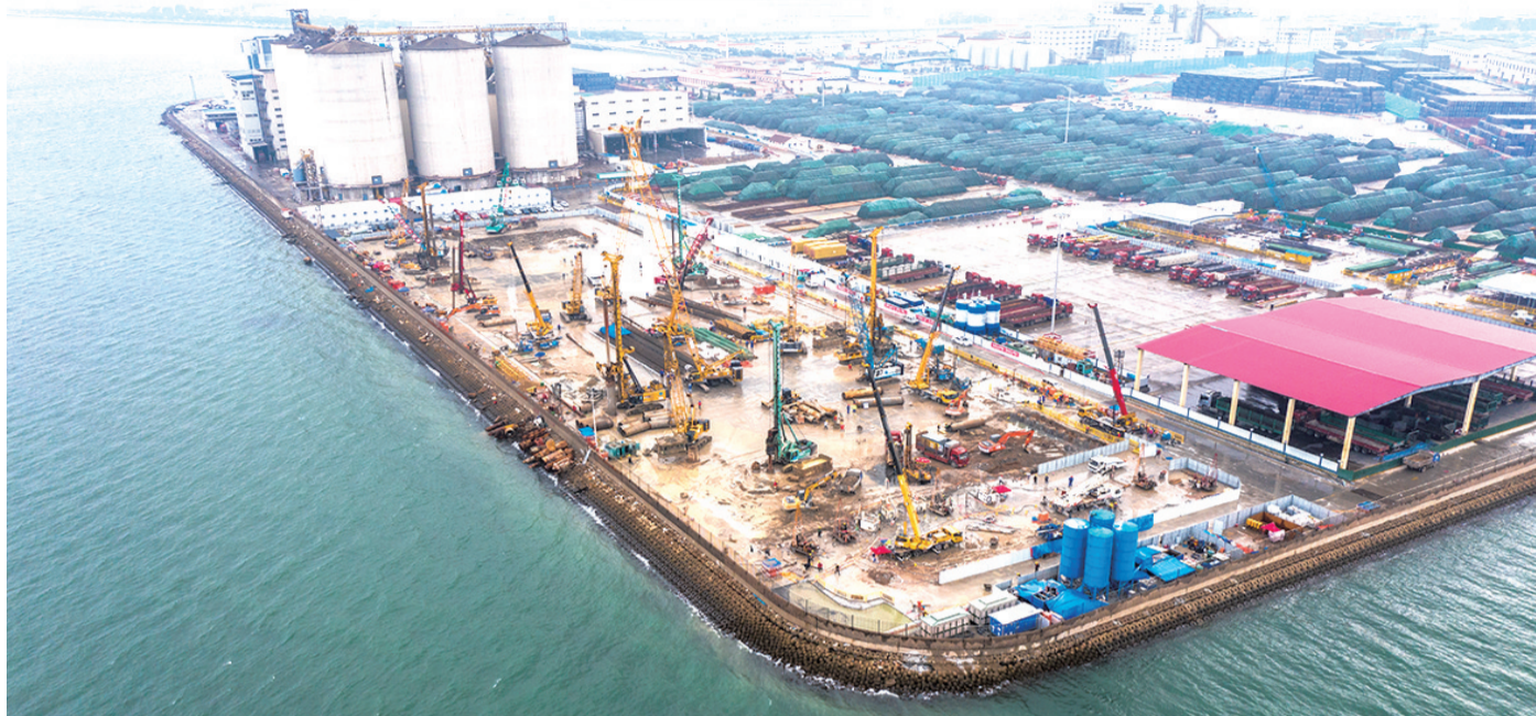
胶州湾二隧青岛端盾构始发井基坑工程现场。青岛国信供图
