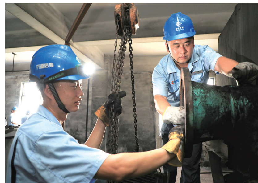
工作人员在检修维护设备。
