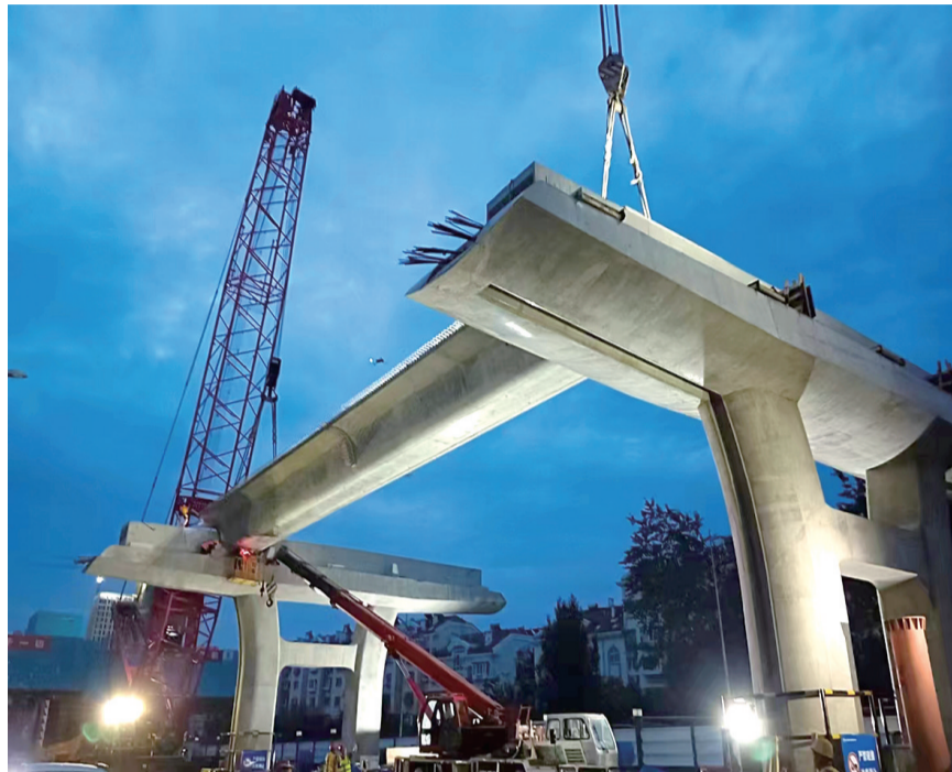
辽阳路快速路(福州路—海尔路段)工程首榀箱梁架设成功。
