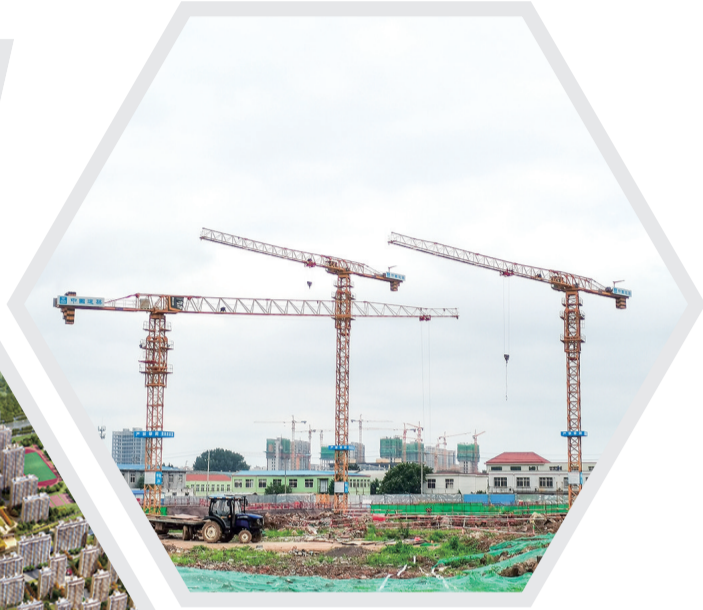
即墨国际智慧城项目开始动工。
