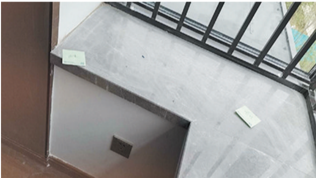
主卧窗台石收缝粗糙且有裂纹。
