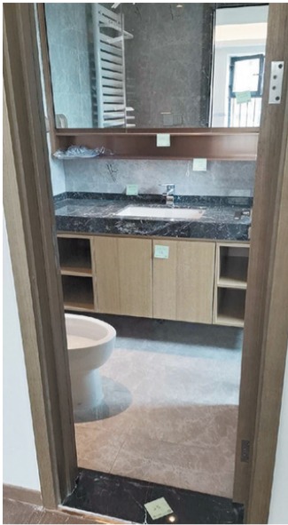
卫生间洗手盆上水管未安装,镜柜灯带未安装。
