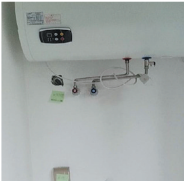
热水器插座缺失,洗衣机插座倾斜。
