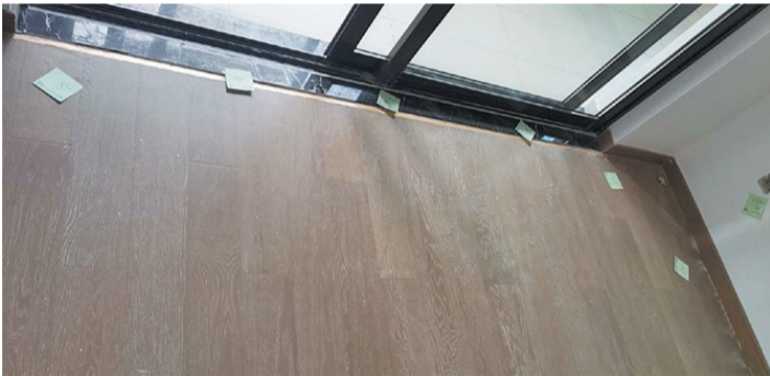
阳台过门石东侧破损,中间开裂破损,西侧断裂。
