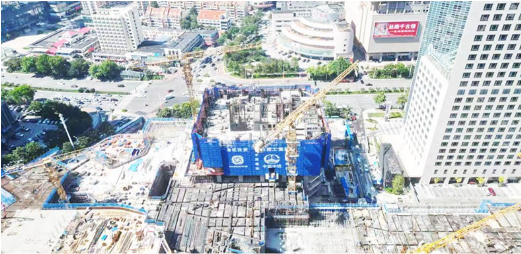
正在建设中的浮山湾总部基地。
