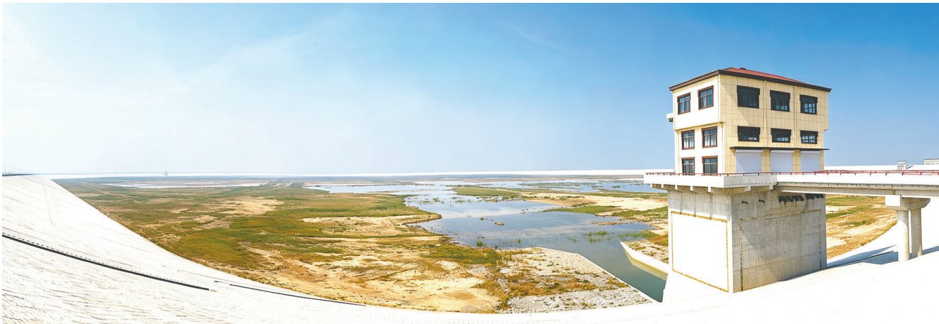
官路水库开启蓄水试运行。
