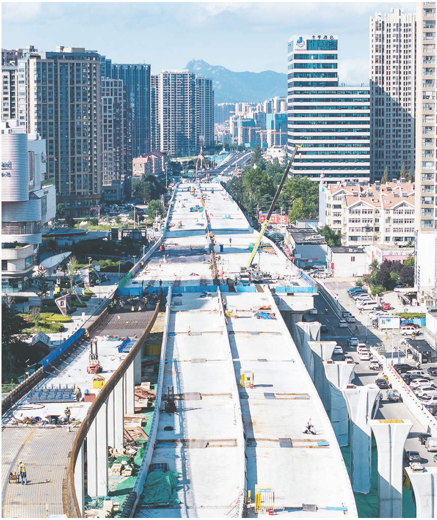
双山隧道及南延配套工程建设正酣。刘栋 摄
