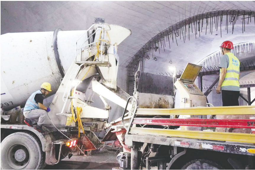
7条在建地铁线路假期施工不停，1.3万名建设者坚守一线。
