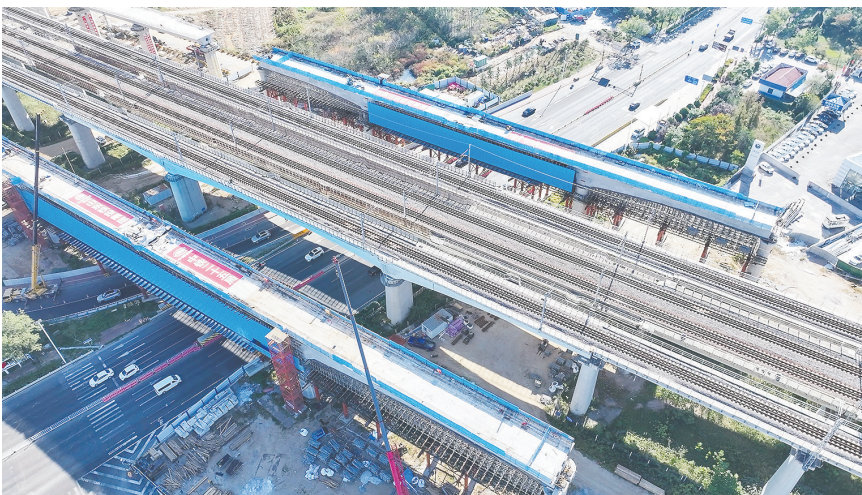
西风河特大桥左右单线连续梁顺利合龙。中铁二十五局供图
