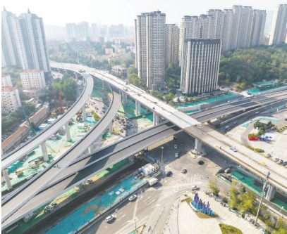
双山隧道及南延配套工程加紧建设。青岛市政开发集团供图
