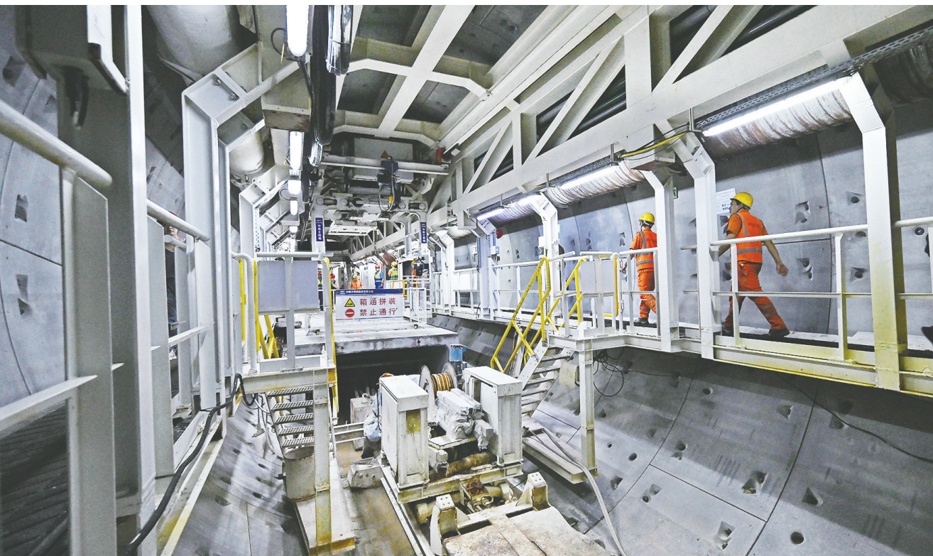
10月2日,中铁十四局建设者在进行盾构机停机后安全检查。新华社发
