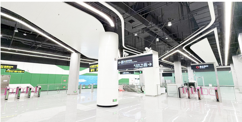
8号线南段站点空间一体化设计赏心悦目。地铁集团供图
