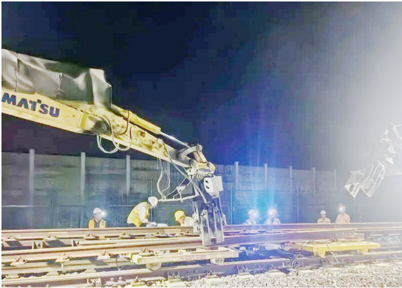
潍宿高铁至青岛连接线刷新进度条。中铁十局供图
