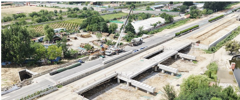
荣潍高速平度段改扩建工程施工现场。平度市交通运输局供图
