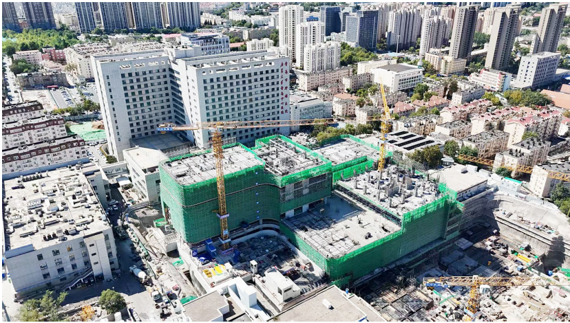
康复大学青岛中心医院二期改扩建项目抢抓施工黄金季。中铁建工集团供图
