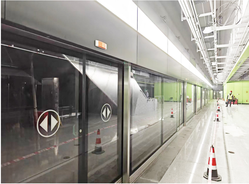
地铁2号线二期打造站后工程“青岛样板”。
