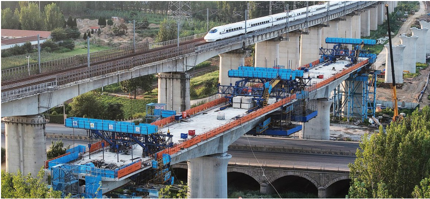
潍宿高铁至青岛连接线两处关键连续梁顺利合龙。中铁十局供图
