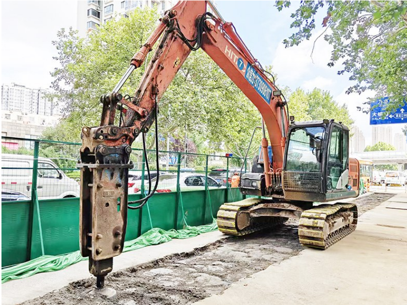
九水西路老旧水网改造项目8月底前将完工。
