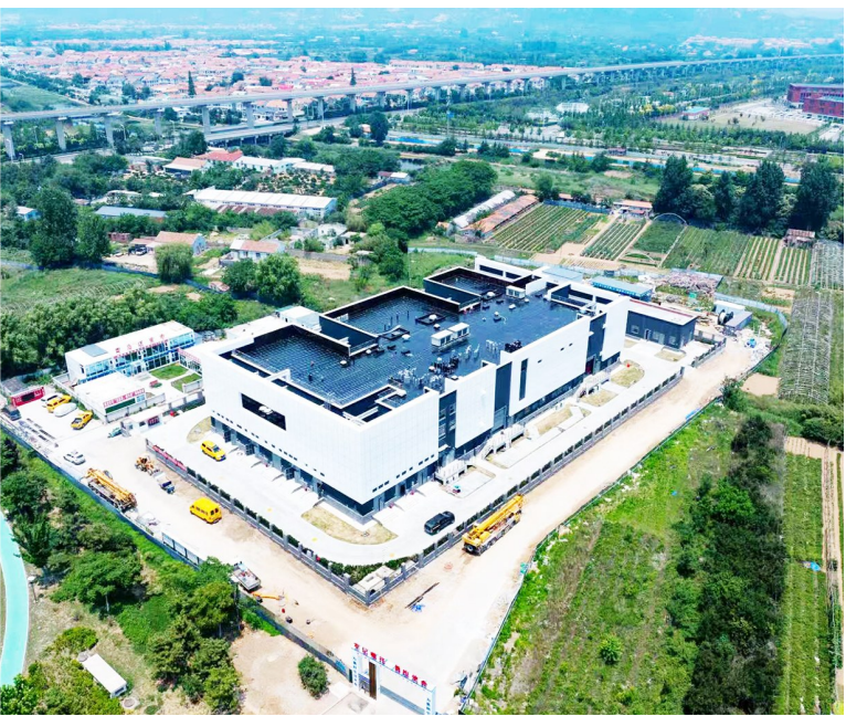
国网青岛供电公司“1号工程”浦里220千伏输变电工程投运。
