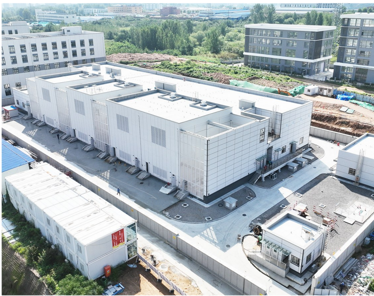
国网青岛供电公司“1号工程”松泉220千伏输变电工程投运，解决黄岛多条线路重载问题。
