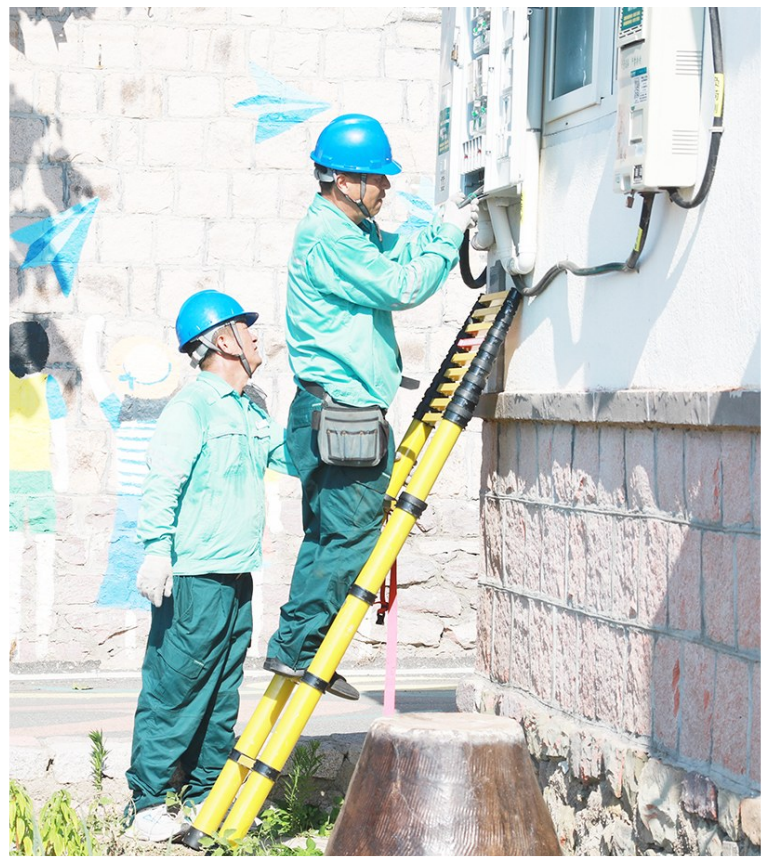
国网青岛供电公司工作人员到即墨莲花田园乡村振兴示范区开展隐患排查。
