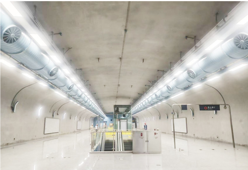
地铁2号线二期工程顺利通过项目工程验收。市住建局供图
