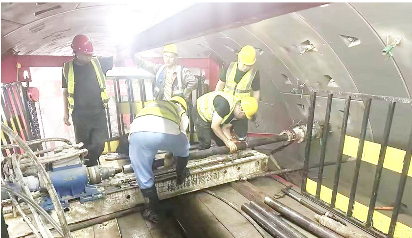
地铁5号线巧解富水地层施工难题。地铁集团供图
