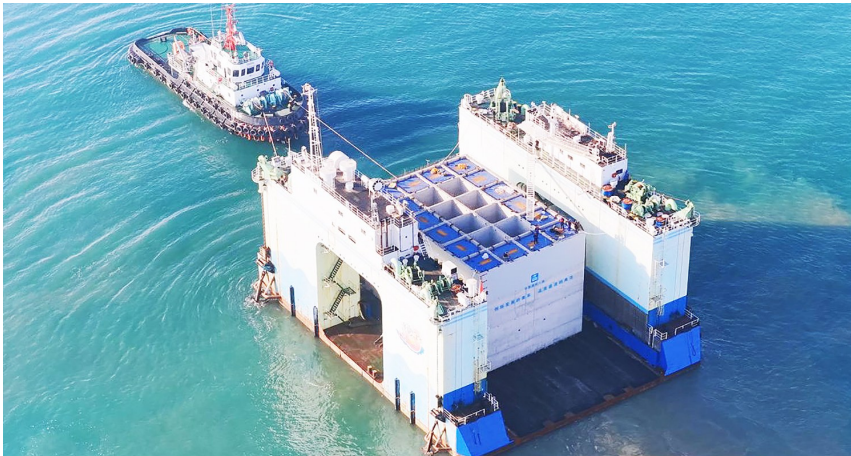
3500吨重“巨无霸”厘米级精准落位。中建八局四公司供图
