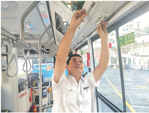
公交驾驶员给车辆空调系统体检。
