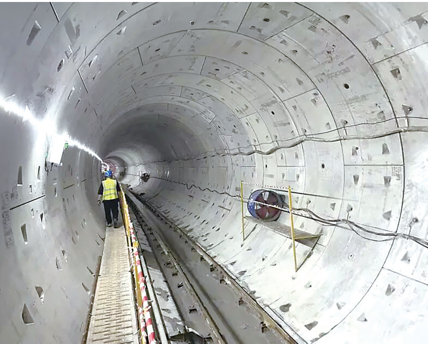
地铁5号线云岭路站站后盾构区间顺利贯通。地铁集团供图
