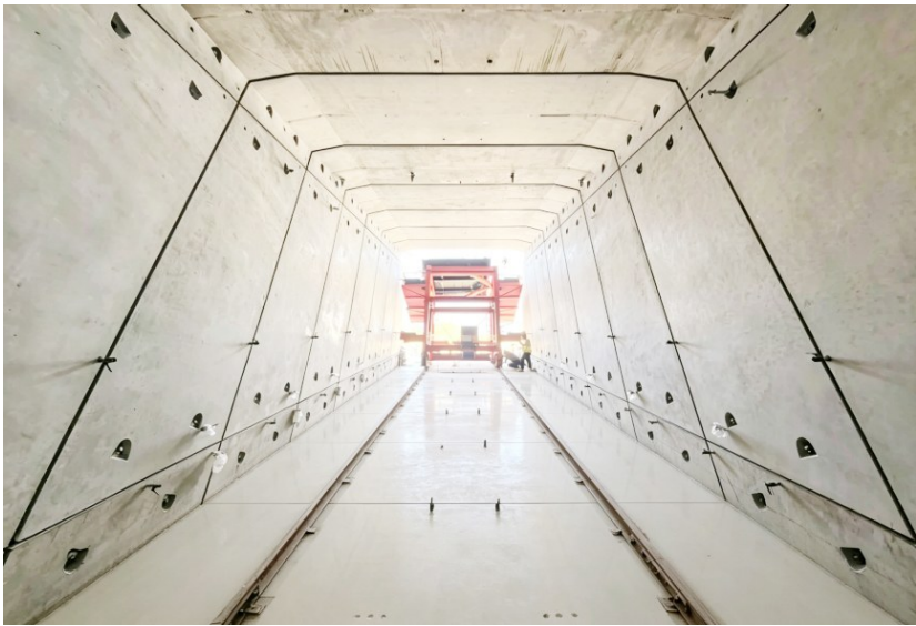
地铁6号线装配式出入口“零误差”拼装完成。地铁供图
