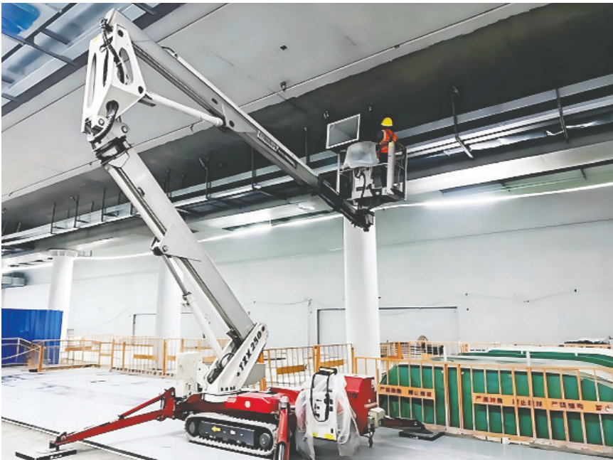
蜘蛛式升降车精准对接顶部管线接口。地铁集团供图
