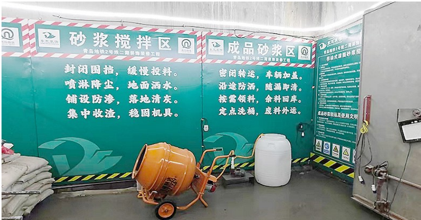
智能喷淋系统让装修告别粉尘漫天。青岛地铁供图
