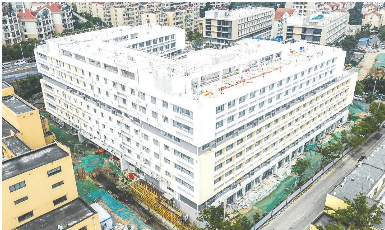
青岛大学浮山校区新建学生宿舍楼。学校供图
