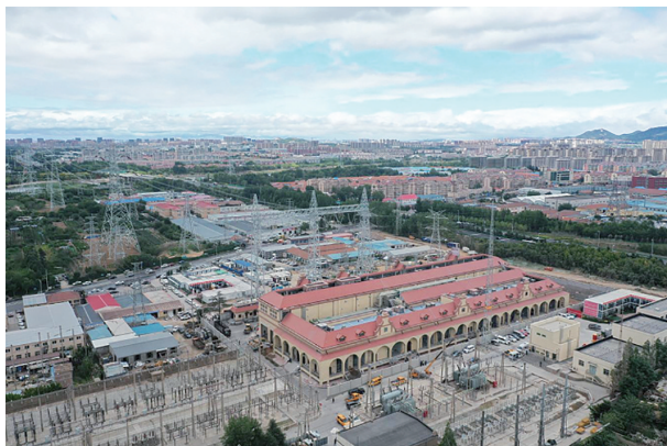
国网青岛供电公司建成全省首座城市核心区500千伏全户内变电站。
