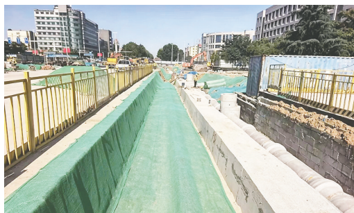
“同槽开挖”实现安全提速降本增效。
