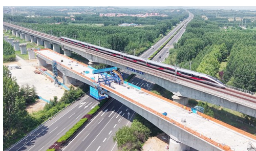
潍宿高铁至青岛连接线跨青兰高速连续梁顺利合龙。 中铁十局供图
