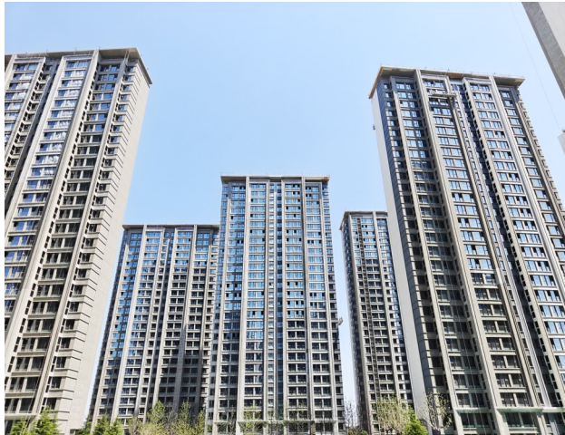
星樾府和璟樾府项目已全面开展装饰装修工作。
