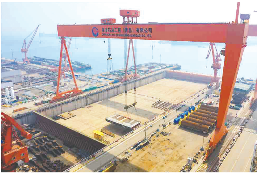
新一代深水专业铺管船完成龙骨安放。西海岸新区供图
