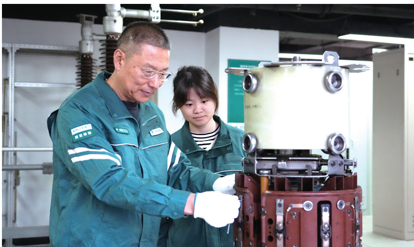
郑强（左）在向徒弟讲解M型有载分接开关切换机构的检修技巧。受访者供图
