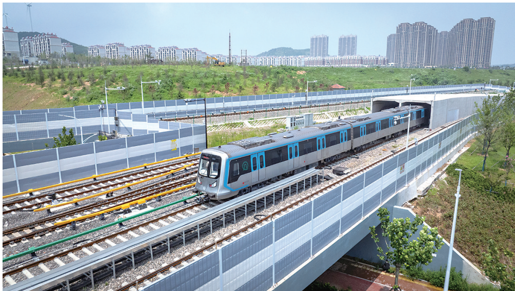
列车全自主运行系统(TACS)在青岛地铁6号线落地。
