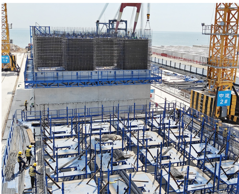
巨无霸沉箱制作中。徐美中 摄
