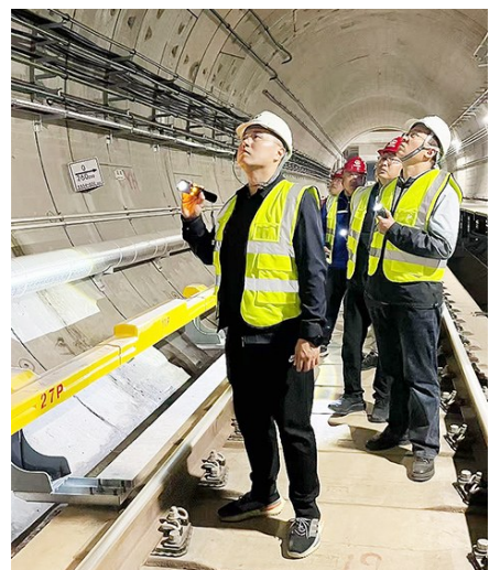
8号线南段土建工程基本完工。市住建局供图
