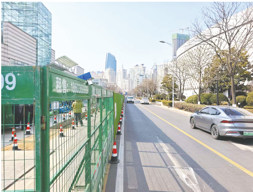
澳门路老旧管网改造吹响完工“冲锋号”。
