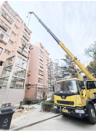
吊车进场施工,开始安装电梯间。
