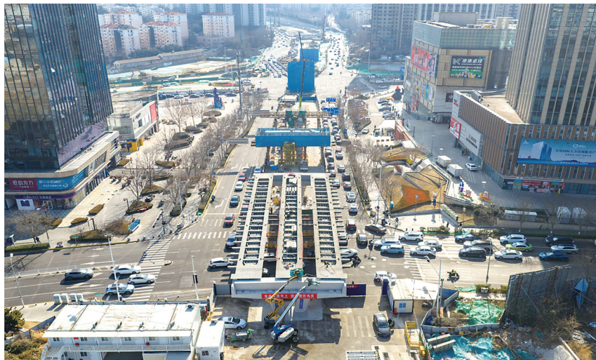
双山隧道及南延配套工程首跨钢箱梁成功架设。青岛市政开发建设集团有限公司供图
