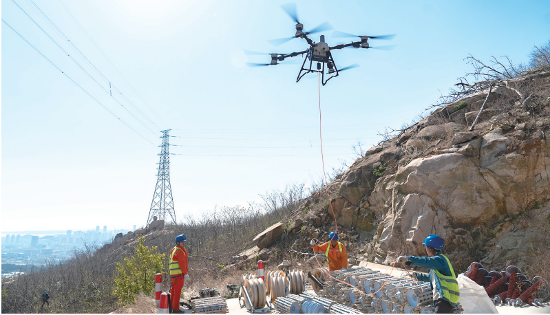
国网青岛供电公司利用大载重无人机等先进工具开展线路附件运输。
