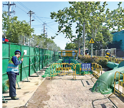
我市提前完成老旧供水管网改造。海润集团供图
