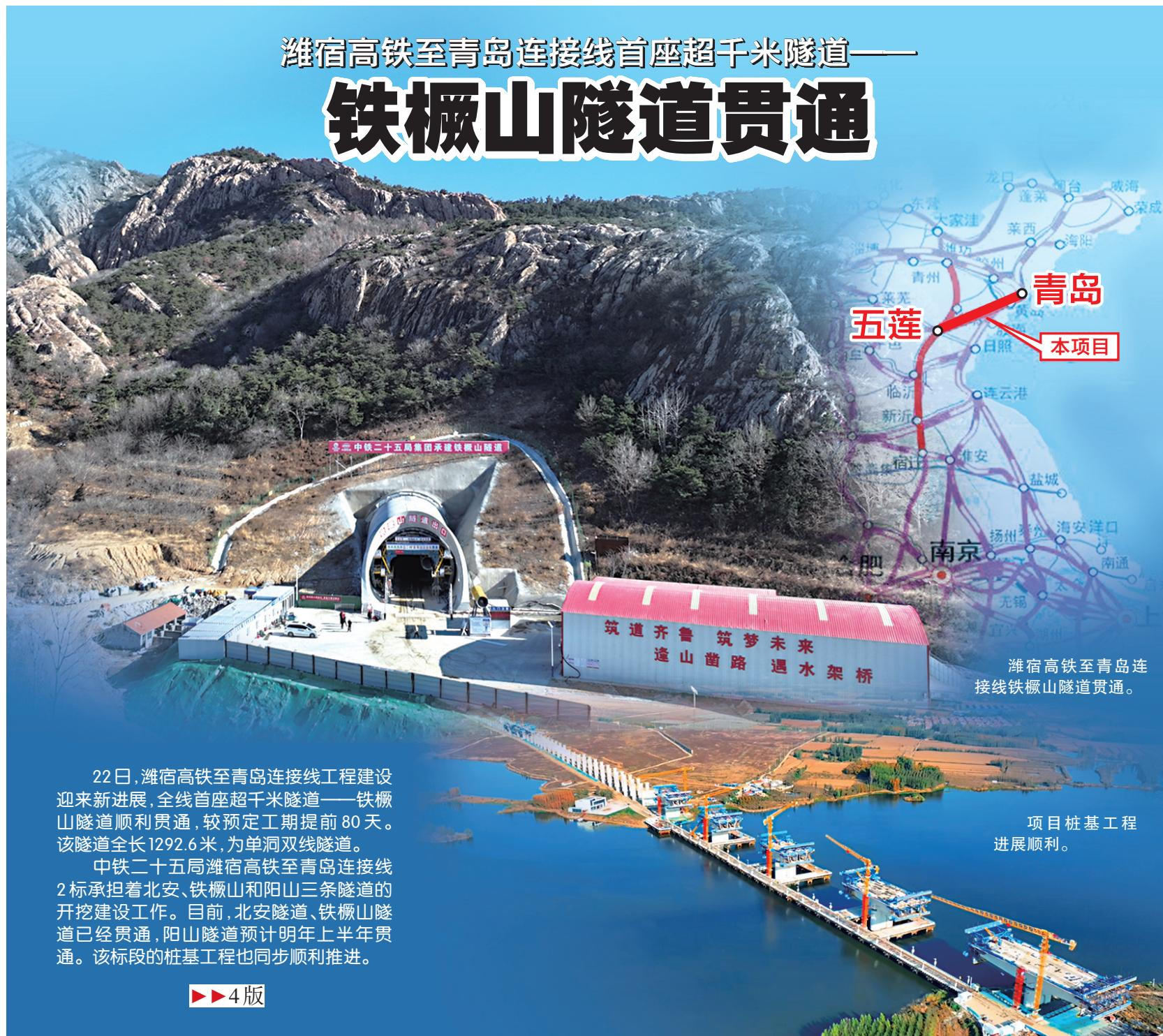
22日,潍宿高铁至青岛连接线工程建设迎来新进展,全线首座超千米隧道——铁橛山隧道顺利贯通,较预定工期提前80天。该隧道全长1292.6米,为单洞双线隧道。
