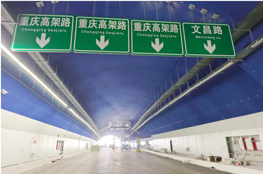
隧道内空中导向标志已完成安装。徐美中 摄
