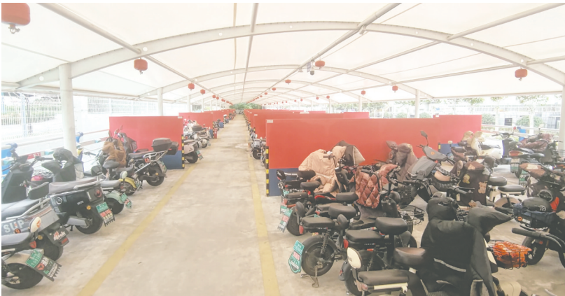
位于海尔工业园的一处电动自行车集中充电点,地面搭起防火墙,棚顶设有消防“灯笼”。刘卓毅 摄
